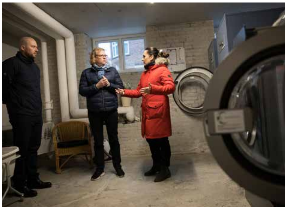
Nye vaskemaskiner og tørretumblere i foreningens vaskekælder sparer andelshaverne for mange penge på el- og vandregningen.
